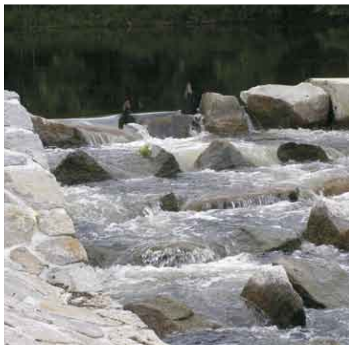
Rybí přechod typ balvanitá rampa na řece Ohři / Fish-passing facility, boulder ramp, on the Ohře river
